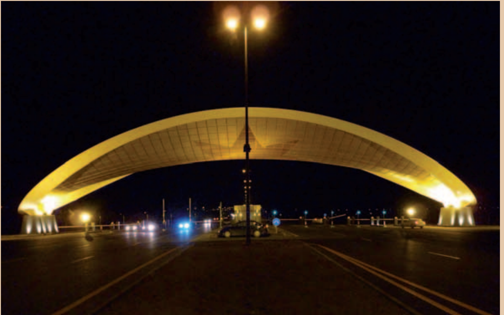
PUERTA DE ENTRADA AEROPUERTO INTERNACIONAL HEYDAR ALIYEV - BAKU (Azerbaián) Proyectación arquitectónica y de estructuras: ARUP - Arq. FREAD DEACON Proyectación constructiva de las estructuras metálicas: WAAGNER BIRO (Stahlbau) Revestimiento chapa estirada: METALLTECH Foto: © Arup
