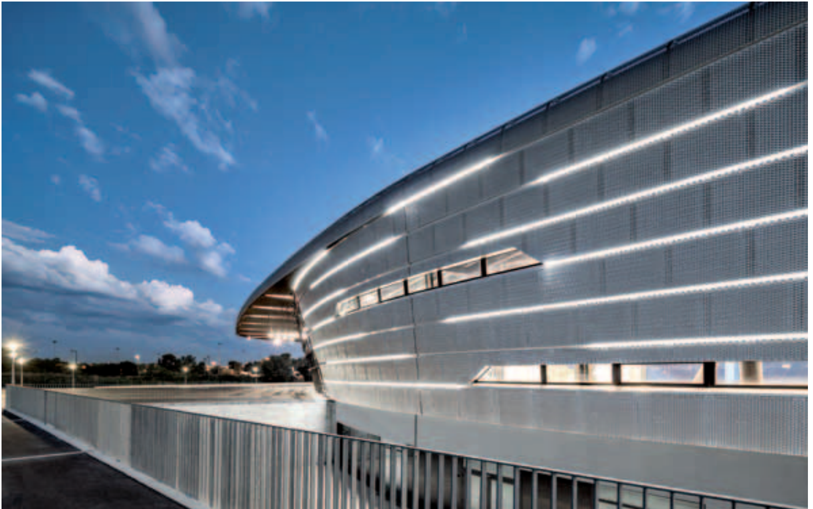
AZUR ARENA - ANTIBES (Francia) Proyecto: FRADIN WECK ARCHITECTURE, AUER + WEBER + ASSOZIIERTE Foto: © Aldo Amoretti
