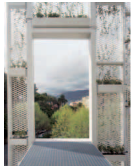
Una "fachada verde" con macetas en varios niveles, colocada delante de la entrada pero separada de ella, para dar un toque especial a la fachada principal. La pared de cristal del edificio refleja la "Green Facade", multiplicándola con un juego de reflejos y transparencias.
