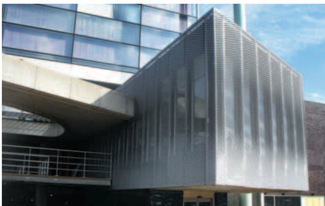
Fachada en chapa estirada con malla de abertura variable. Eficiente partesol con transparencia gradual que permite el control de las radiaciones solares sobre las paredes acristaladas.
