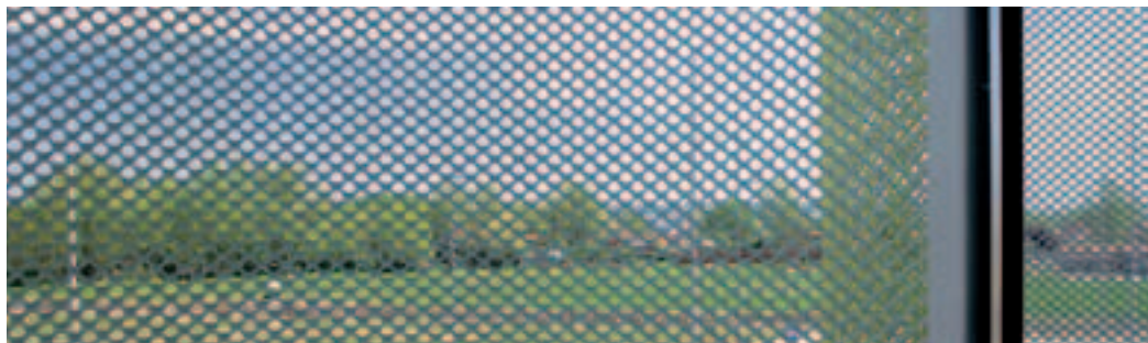
Esbeltas columnas semicirculares de metal estirado que dan transparencia y movimiento a la fachada. Las letras impresas se perciben de forma dinámica por parte de quien viaja en el tren a alta velocidad.
