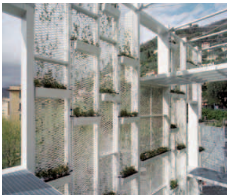
Una "fachada verde" con macetas en varios niveles, colocada delante de la entrada pero separada de ella, para dar un toque especial a la fachada principal. La pared de cristal del edificio refleja la "Green Facade", multiplicándola con un juego de reflejos y transparencias.
