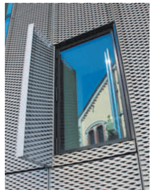
Envoltura vertical del edificio, falso techo horizontal, "aletas" laterales como partesoles para las aberturas ventanales; para un doble objetivo de revestimiento y sombreado.
