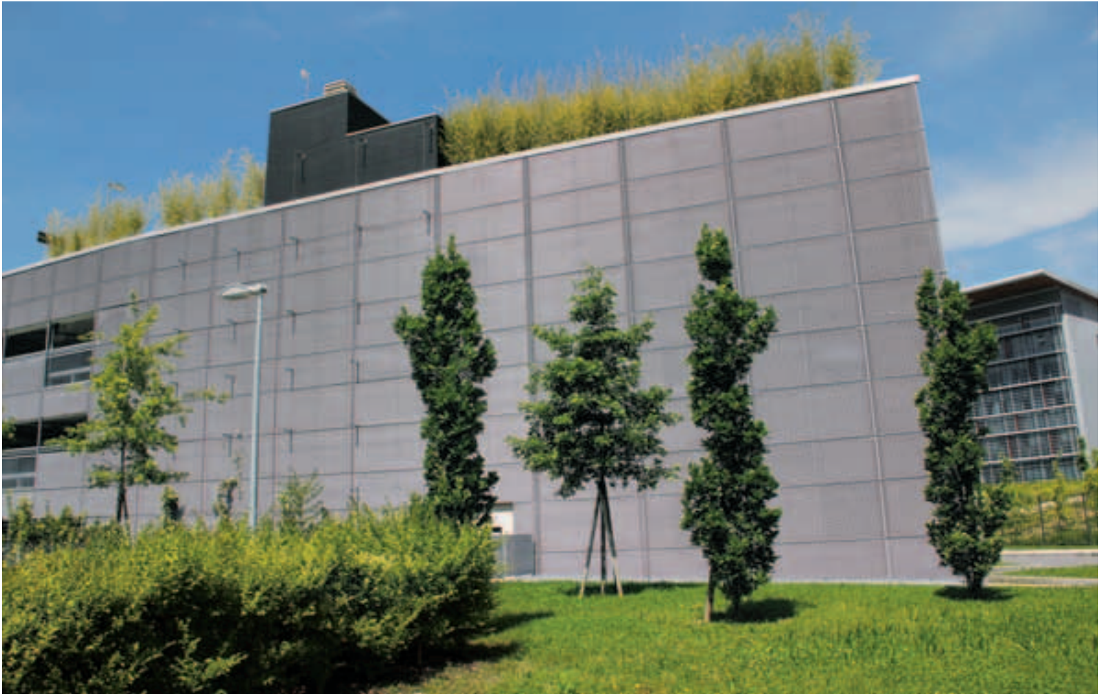
NUEVO HOSPITAL PAPA GIOVANNI XXIII - BERGAMO (Italia) Proyecto: Estudio Arq. TRAVERSI+TRAVERSI Revestimiento chapa estirada: METALLTECH Foto: © Archivio Longhigroup
